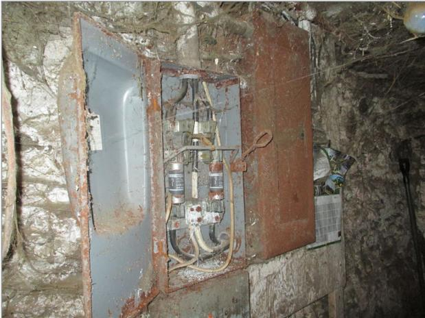
**Figure 4.** Panneau de sectionneur principal corrodé.
