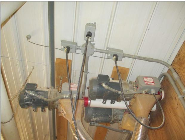
**Figure 7.** L'utilisation de fiches et de prises d'usage courant n'est pas recommandée pour l'environnement des bâtiments de ferme.
