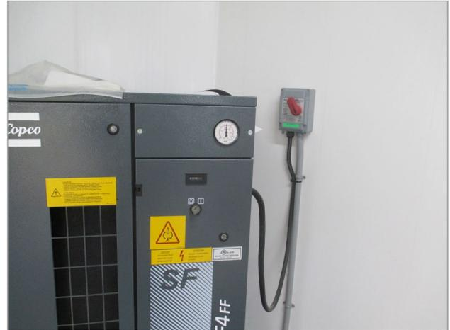
**Figure 8.** Compresseur alimenté par un fil câblé.
