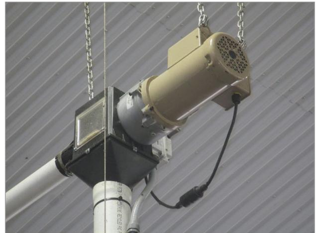
**Figure 9.** Les fiches et les prises à l'épreuve de l'eau avec fils câblés sont recommandées pour l'environnement des bâtiments de ferme.
