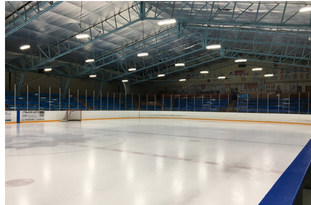
Modernisation de la George Bell Arena à Toronto.
