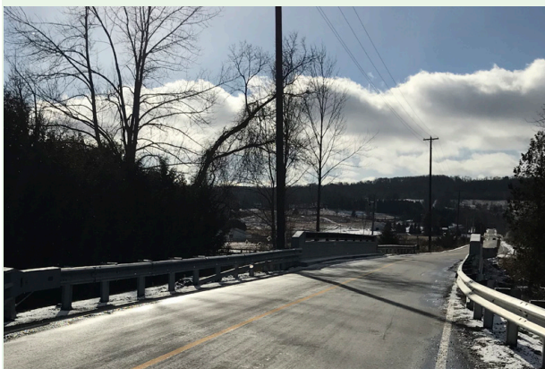
Le pont Grange Sideroad à Caledon, après sa réfection.
