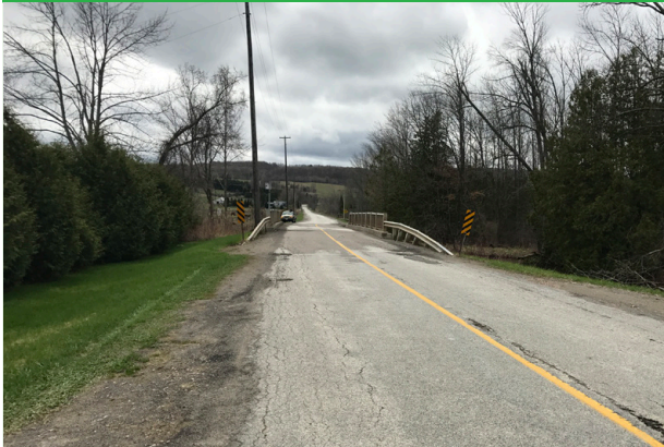
Le pont Grange Sideroad à Caledon, avant sa réfection.
