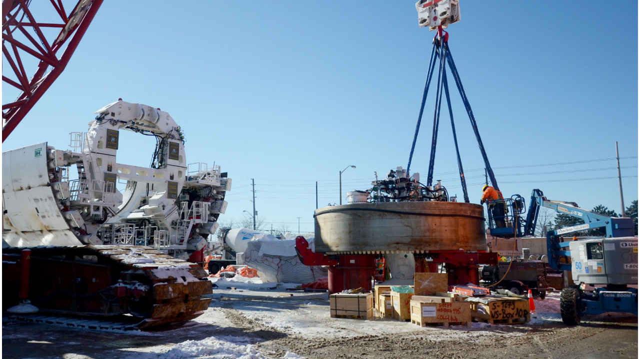
Montage d'un tunnelier dans le prolongement du métro de Scarborough à Toronto.
