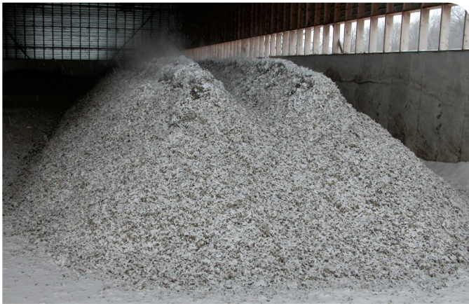
Figure 31. Structure d'entreposage de fumier solide recouverte (V2) et dotée de murs à lattes
