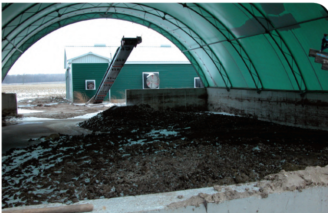
Figure 43. Vue avant d'une installation d'entreposage, à toit, pour le fumier liquide (M2)
