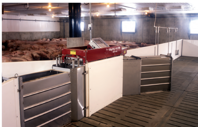
Figure 35. Caillebotis d'un bâtiment pour l'entreposage de fumier liquide sous le bâtiment (V5)
