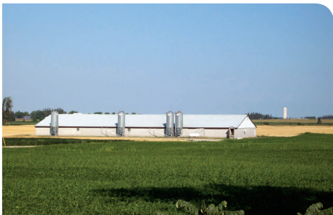
Figure 14. Extérieur d'un bâtiment d'élevage de porcs de finition avec réservoirs d'entreposage du fumier liquide sous le bâtiment
