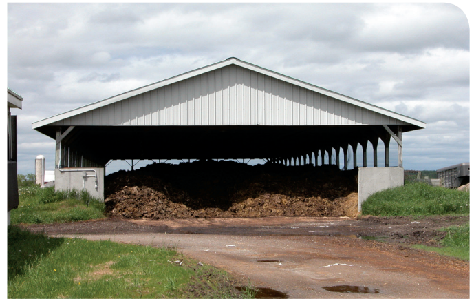
Figure 32. Structure d'entreposage de fumier solide recouverte (V2) et dotée de murs à lattes
