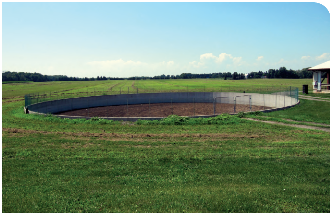
Figure 41. Structure d'entreposage enterrée, non couverte, à parois verticales, pour le fumier liquide (M1)
