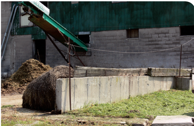
Figure 34. Entreposage de fumier solide non couvert avec entreposage couvert à ruissellement du liquide (V4)
