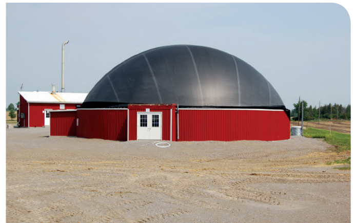
Figure 37. Base d'entreposage de fumier liquide surélevée avec couvercle de dôme gonflable bien scellé visible (V6)
