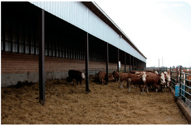
Figure 24. Extérieur d'une étable à bovins de boucherie ouverte sur le devant avec parc
