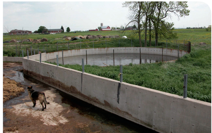
Figure 39. Entreposage de fumier solide non couvert à l'extérieur avec une structure non recouverte pour les eaux de ruissellement (L1)
