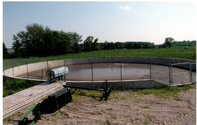
Figure 42. Structure non couverte, au-dessus du sol, à parois verticales, pour l'entreposage du fumier liquide et rampe d'accès pour le nettoyage (M1)
