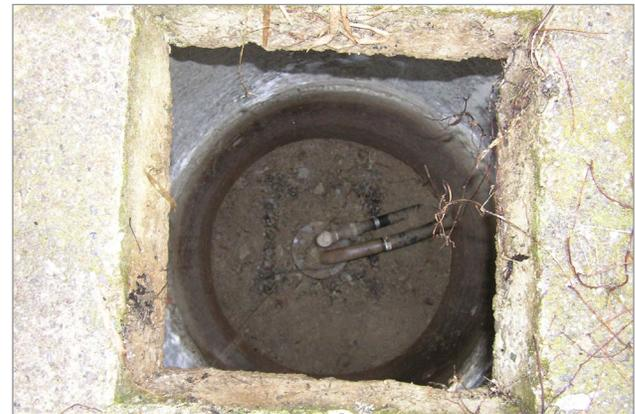
**Figure 7.** Fosse de visite existante créée par la construction d'un puits foré à la sondeuse dans un ancien puits de grand diamètre. Photo : Mary John Conboy, Centre des sciences de l'Ontario.
