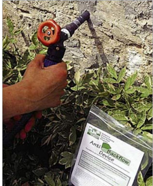
**Figure 3.** Installez des dispositifs anti-refoulement sur tous les robinets extérieurs. Ces dispositifs ne coûtent que quelques dollars et sont offerts en laiton ou en plastique.
