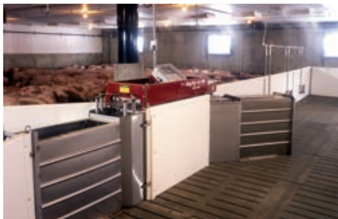
Figure 35. Caillebotis d'un bâtiment pour l'entreposage de fumier liquide sous le bâtiment (V5)
