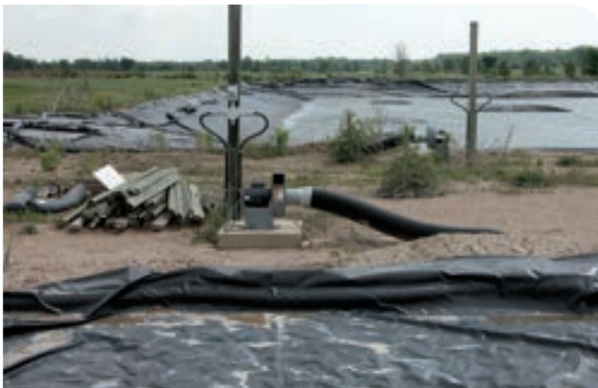
Figure 36. Couverture-bâche qui ferme bien, à pression négative, d'une structure en terre pour l'entreposage du fumier liquide (V6)
