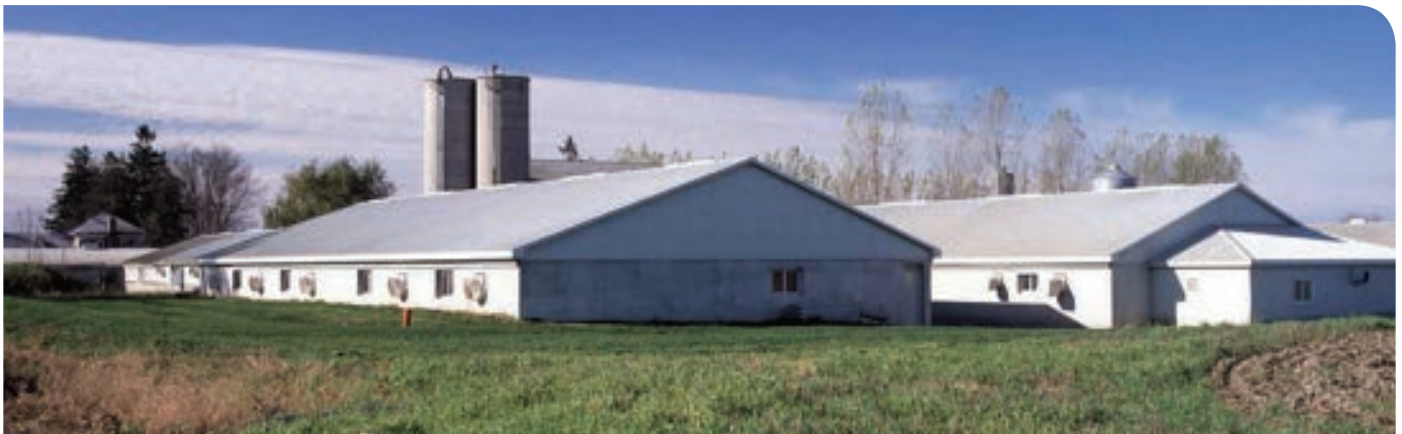
Figure 13. Extérieur d'un bâtiment d'élevage de truies d'un étage*
