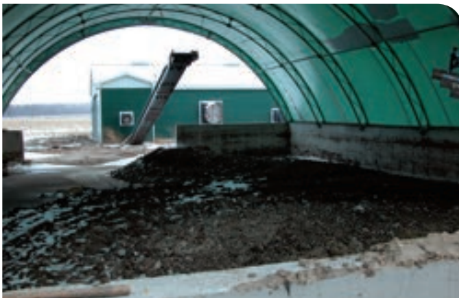
Figure 43. Vue avant d'une installation d'entreposage, à toit, pour le fumier liquide (M2)
