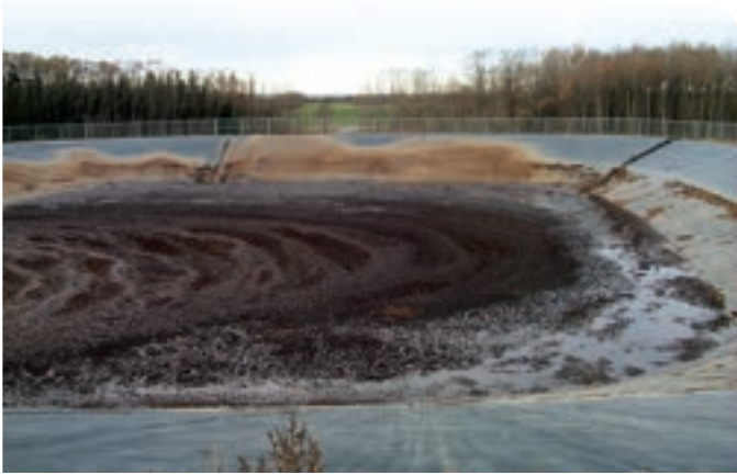
Figure 44. Type en terre de structure d'entreposage de fumier — noter les parois inclinées et l'absence de couverture (H1)
