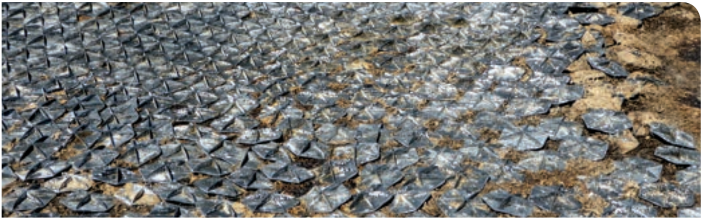
Figure 40. Structure ronde d'entreposage de fumier liquide avec couvercle permanent flottant formé de disques hexagonaux en plastique (L2)
