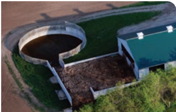
Figure 38. Structure non recouverte pour les eaux de ruissellement (L1)
