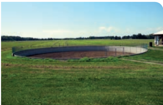
Figure 41. Structure d'entreposage enterrée, non couverte, à parois verticales, pour le fumier liquide (M1)
