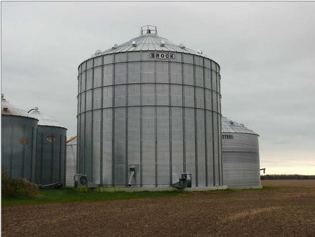
**Figure 1.** Grosse cellule de stockage dotée de deux ventilateurs centrifuges montés à travers la paroi latérale. Cette cellule de stockage est pourvue de nombreuses bouches d'air qui font le tour du toit et sont placées à environ 2 m (6 pi) derrière le débord de toit.
