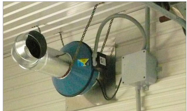
Figure 3. Ventilateur mural servant à introduire de l'air frais dans la pièce abritant l'évaporateur lorsque le pressostat du brûleur en commande la mise en marche.
