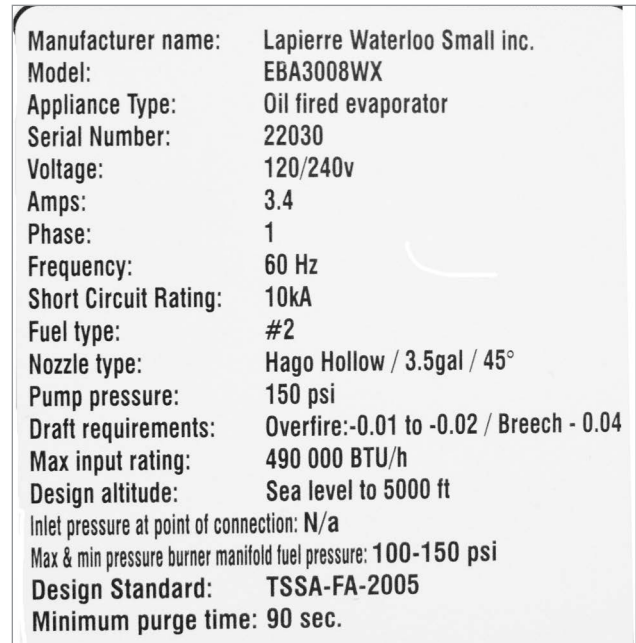
Figure 6. Exemple de plaque signalétique apposée sur un évaporateur de sirop d'érable alimenté au mazout.
