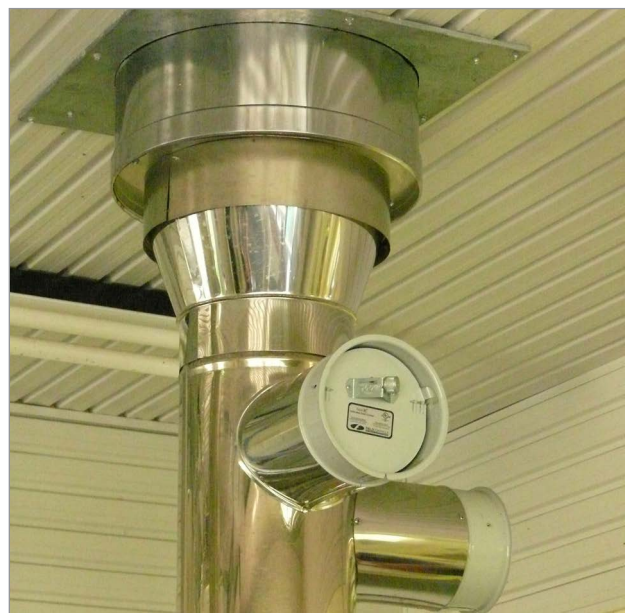
Figure 9. Cheminée en acier inoxydable à double paroi entourant le tuyau de ventilation à l'endroit où il traverse un plafond, un plancher ou un mur isolé.
