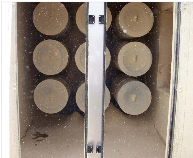
Figure 5. Cet échangeur de chaleur utilise des filtres à air cylindriques et est muni d'un dispositif de rinçage à contre-courant automatique permettant de les nettoyer régulièrement. Les filtres sont accessibles et peuvent être facilement retirés et nettoyés.
