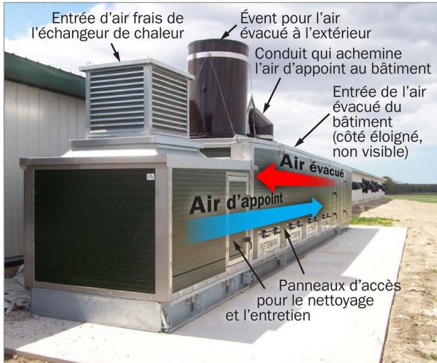
Figure 3. Cet échangeur de chaleur est conçu pour assurer une ventilation complète pendant les mois d'hiver. Le module central est situé à l'intérieur du grand boîtier. L'air évacué et l'air d'appoint circulent dans des directions opposées dans le module central et la chaleur passe entre les deux.
