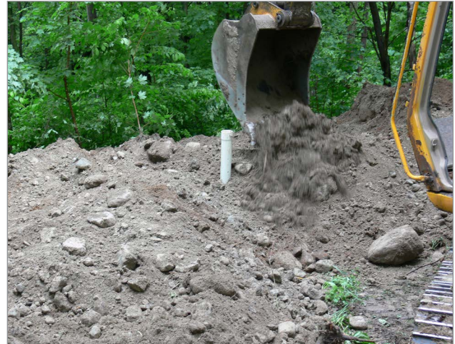
Figure 9. Pour mettre hors-service un conteneur d'élimination qui est plein, on utilise la terre de déblai provenant du trou creusé pour accueillir le nouveau conteneur d'élimination. Pour peu que le travail ait été bien planifié, une entreprise d'excavation réalisera les travaux en quelques heures seulement.
