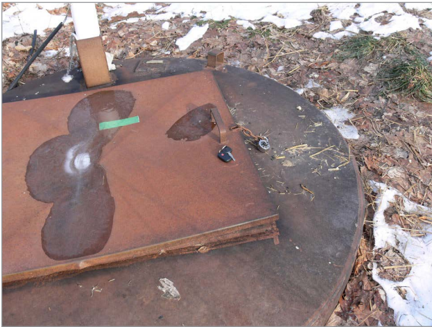
Figure 6. Les trappes doivent être grandes, solides, faciles à ouvrir par n'importe quel temps, et cadenassées entre les utilisations. L'évent, qui fait environ 10 cm x 10 cm (4 po x 4 po) et qui se trouve à côté de la trappe doit seulement avoir une ouverture suffisante pour permettre l'entrée des mouches et des coléoptères qui se nourrissent des cadavres.
