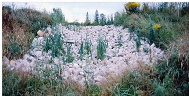
**Figure 3.** Déversoir enroché à la sortie d'une voie d'eau gazonnée.
