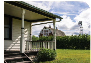
Logement pour la main-d'œuvre à temps plein*
