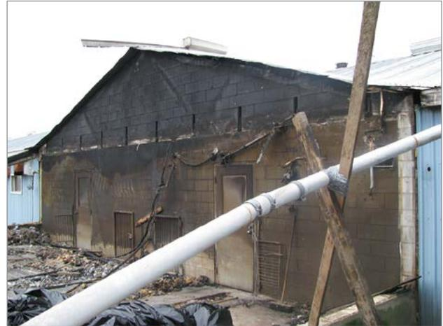
**Figure 7.** Exemple d'une séparation coupe-feu demeurée intacte qui a été efficace et a empêché les flammes de se propager à travers le bâtiment d'élevage.
