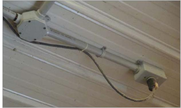
**Figure 2.** Branchement à une prise d'un appareil électrique à connexion provisoire dans une aire abritant des animaux d'élevage. *Source : Heartland Farm Mutual, Ontario.*
