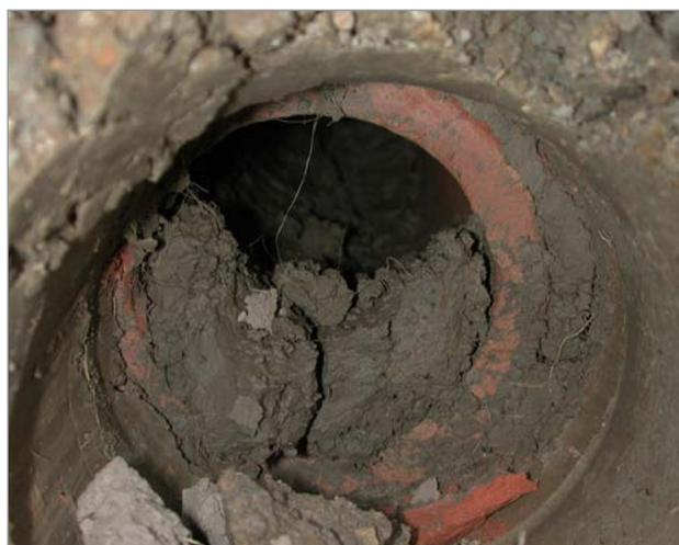
**Figure 7.** Tuyau de drainage contenant passablement de sédiments à la suite de l'éclatement du tuyau.
