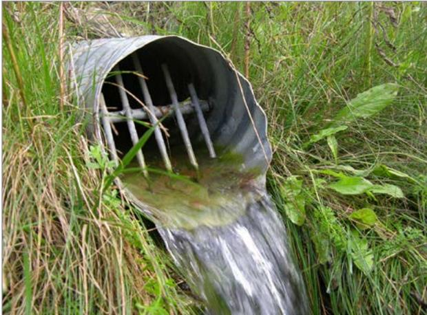
**Figure 3.** Bouche de décharge dotée d'une grille à l'épreuve des rongeurs.
