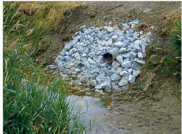
**Figure 4.** Bouche de décharge avec protection contre l'érosion et tuyau arrivant au-dessus du niveau de l'eau.
