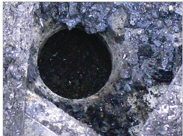
**Figure 2.** Cet orifice de vidange gravitaire ouvert donnant sur une fosse inférieure serait la source de méthane à l'origine d'un incendie dans la pouponnière d'un élevage porcin.
