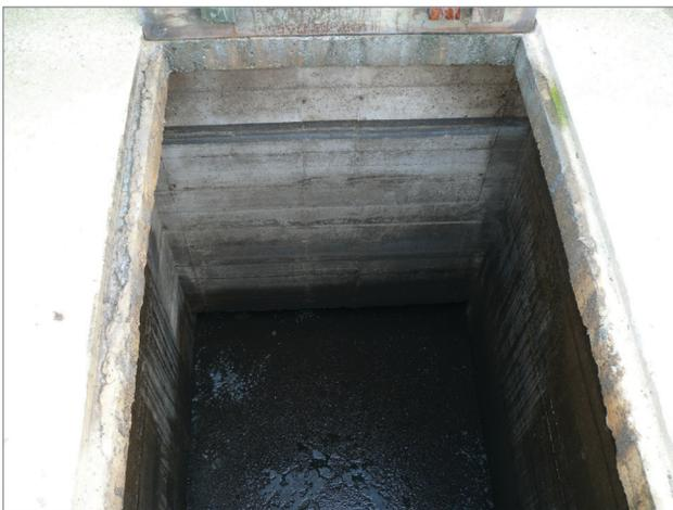
**Figure 3.** Dans une structure non mise à l'air libre, si la fosse de vidange est dotée d'un déflecteur, l'espace libre se trouvant au-dessus de la surface du lisier se pressurise une fois que le niveau du lisier atteint le bas du déflecteur.
