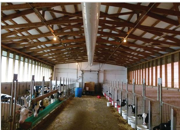
**Figure 1.** Un système de VGDAPP améliore l'aération dans une étable à veaux.
