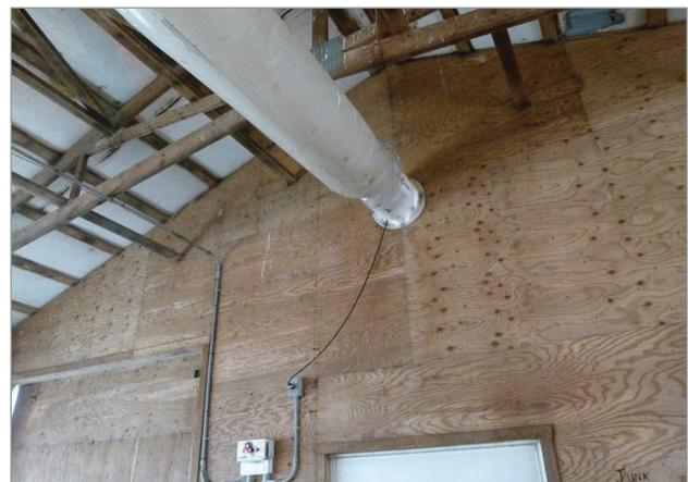
**Figure 2.** La grosseur de la gaine de diffusion d'air doit convenir à la capacité du ventilateur.
