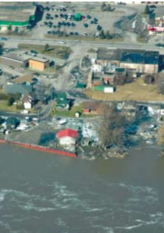
Dunnville, après que l'inondation et la glace aient causé des dommages importants le long de la rivière Grand en Ontario.
