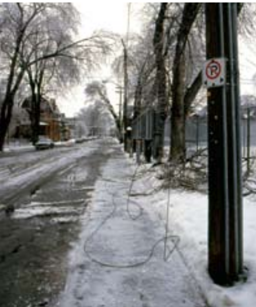
Des poteaux d'électricité en pleine tempête hivernale.
