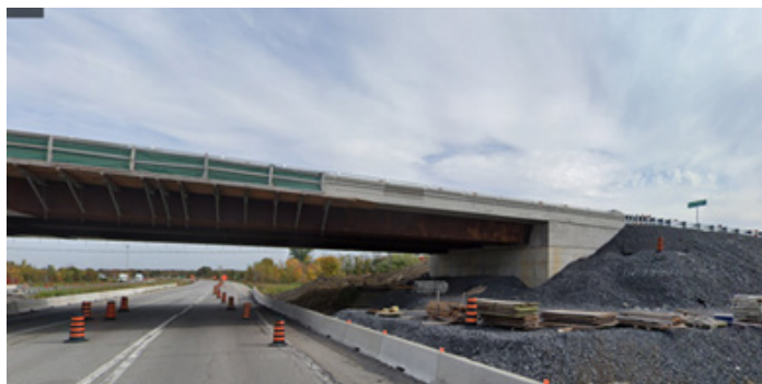
Vue vers l'est du côté ouest du remblai.
