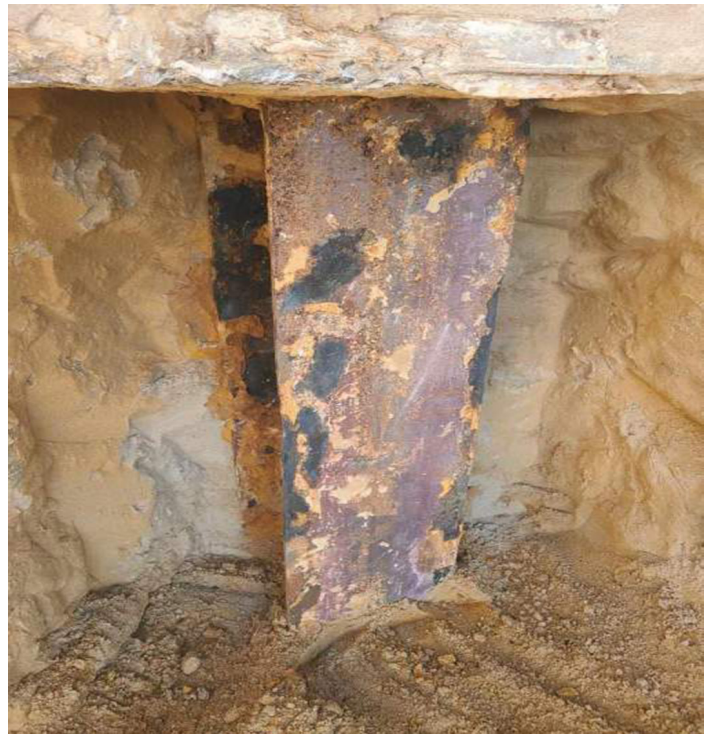
Figure 3 : Le pieu W3 de l'avenue Woodroffe avant un décapage au jet
