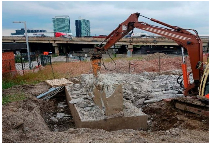
Figure 1 : Démolition des fondations d'un pont abandonné à l'échangeur de la rue Leslie
