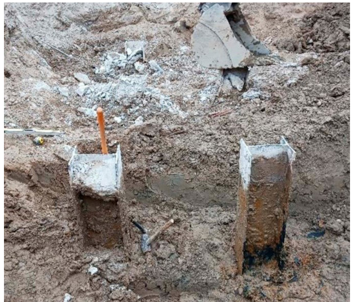
Figure 2 : Pieux en H à découvert à l'échangeur de la rue Leslie
