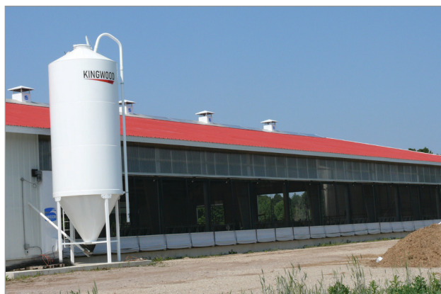
Figure 2. Une étable ventilée naturellement avec une ouverture des parois latérales et une ventilation faîtière (cheminées).
