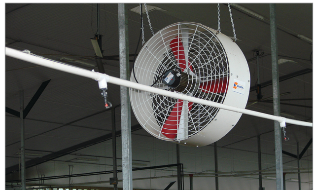
Figure 12. Utiliser des asperseurs avec les ventilateurs pour mouiller les vaches et leur procurer un refroidissement par évaporation.
