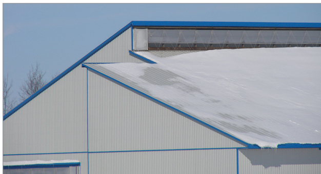
Figure 5. Toit débordant créant une ouverture de faîte.
