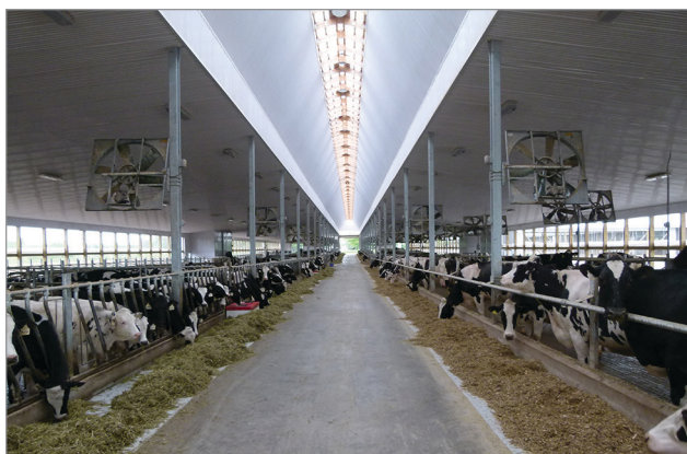
Figure 1. Étable laitière dont les combles sont entièrement isolés.
