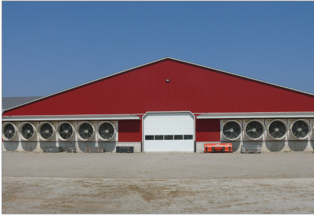
Figure 7. Ventilation longitudinale pour rafraîchir les vaches laitières.
