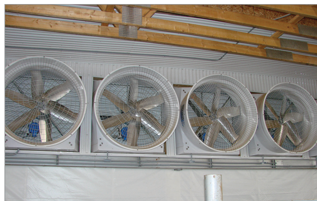
Figure 9. Les ventilateurs fournissent l'énergie pour déplacer et renouveler l'air dans l'étable.
