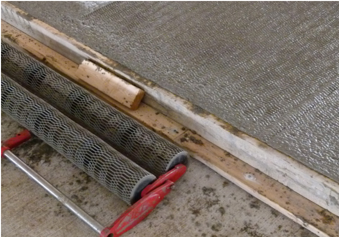
Figure 1. Ponceuse à sautellement servant à créer une surface texturée.
