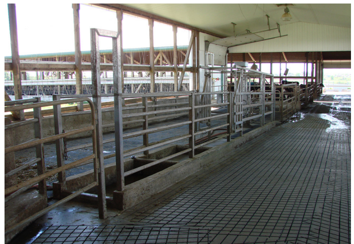
Figure 3. Rainures en forme de losange pour améliorer l'adhérence.
