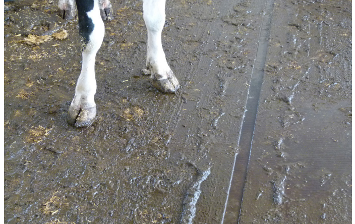
Figure 4. Rainurage de la surface au moyen du fraisage pour améliorer l'adhérence.
