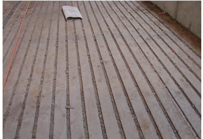
Figure 2. Rainures longitudinales afin d'améliorer l'adhérence.
